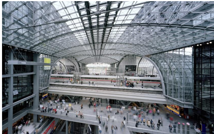
Figur 43 - Hauptbahnhof Berlin. En station som har korsande tågspår i flera riktningar på pelare.
