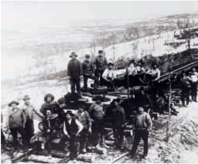
Rälsläggning av Riksgränsbanan 1902.
